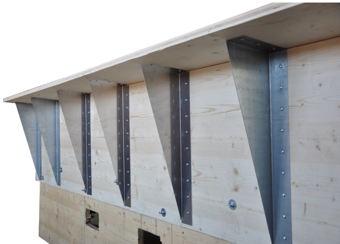
Abb. 7: Beispiel des Dachrandtyps 4.6, Aufnahme vom Praxistest
